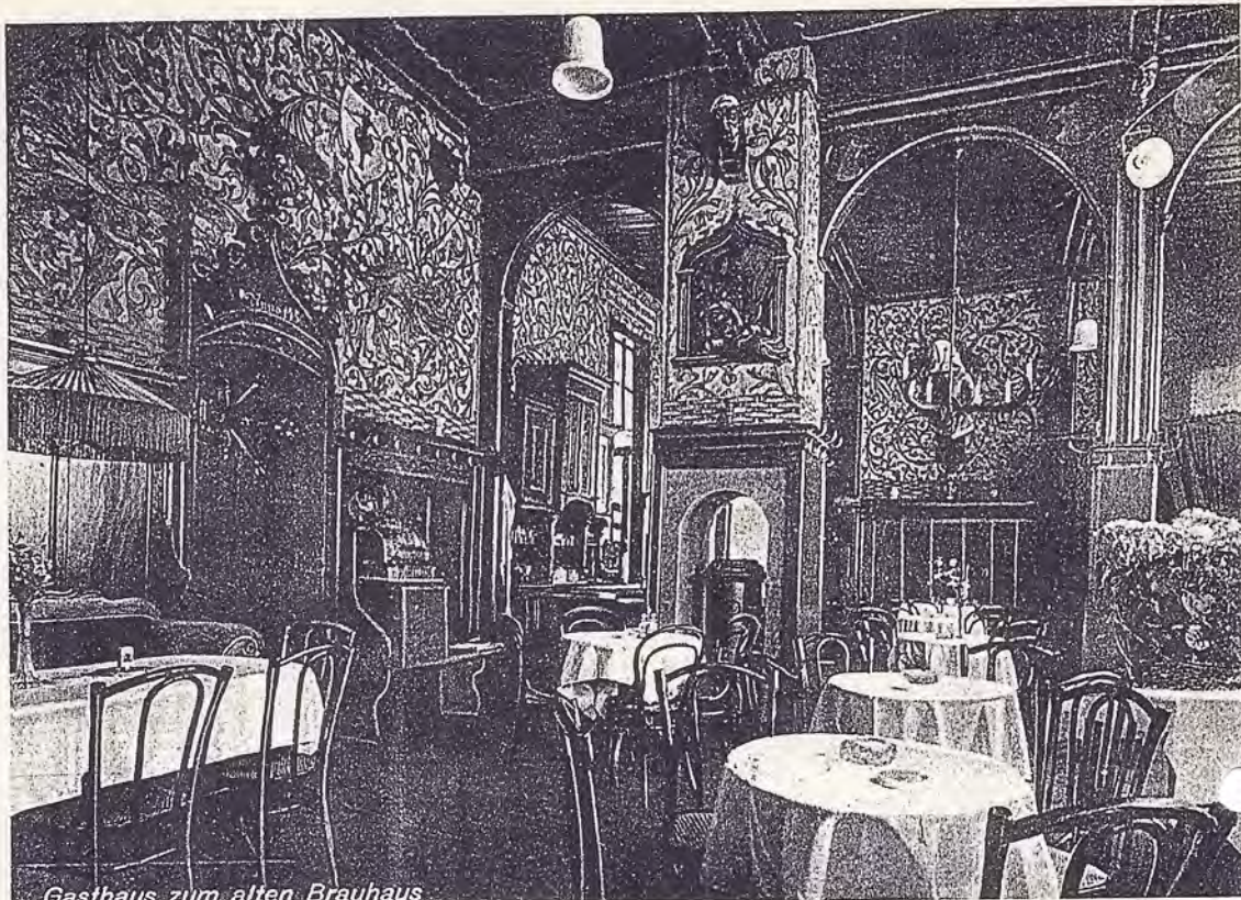
Altes Brauhaus im Kötterhagen, Innenräume nach der Renovierung von 1934
