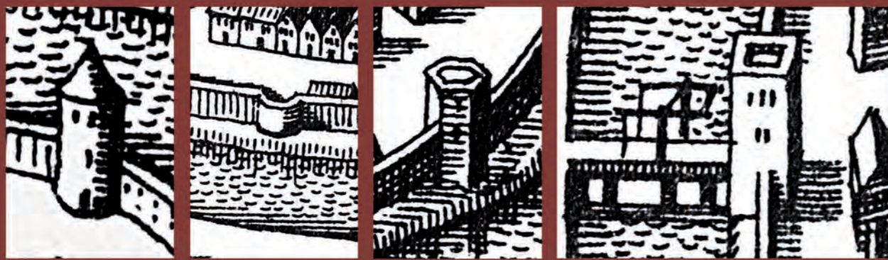
Tor- und Turmvarianten: v.l.: Rundturm, Halbschalenturm, sechseckiger Wehrturm, rechteckiges Stadttor (Recklinghäuser Tor)
